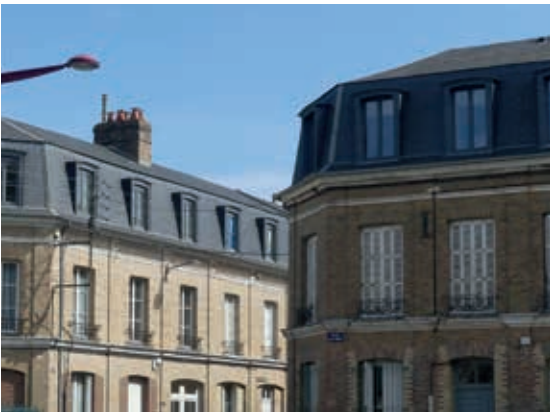
> Toit à la Mansart
